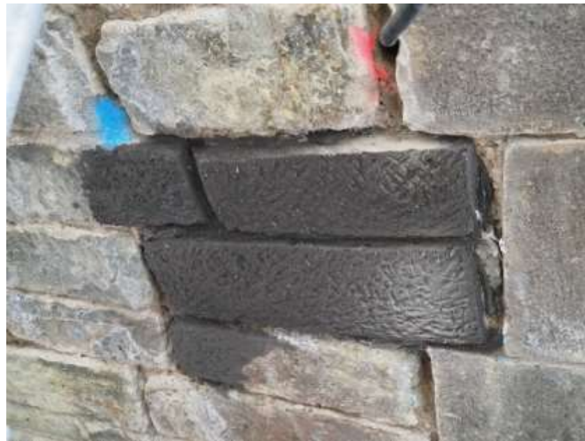
Mortier pierre et ciment fondu. (éclaircissement au séchage)
