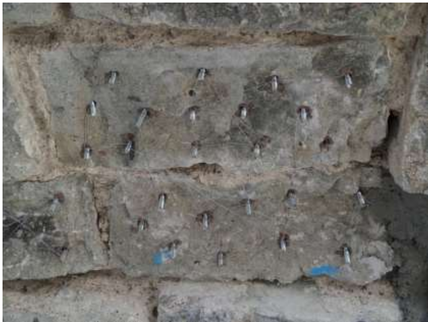
Scellement de tiges filetées et trame en fil de fer (tout inoxydable).
