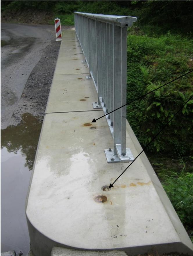
Deux chevilles chimiques par élément reçoivent les ancrages métalliques verticaux.
