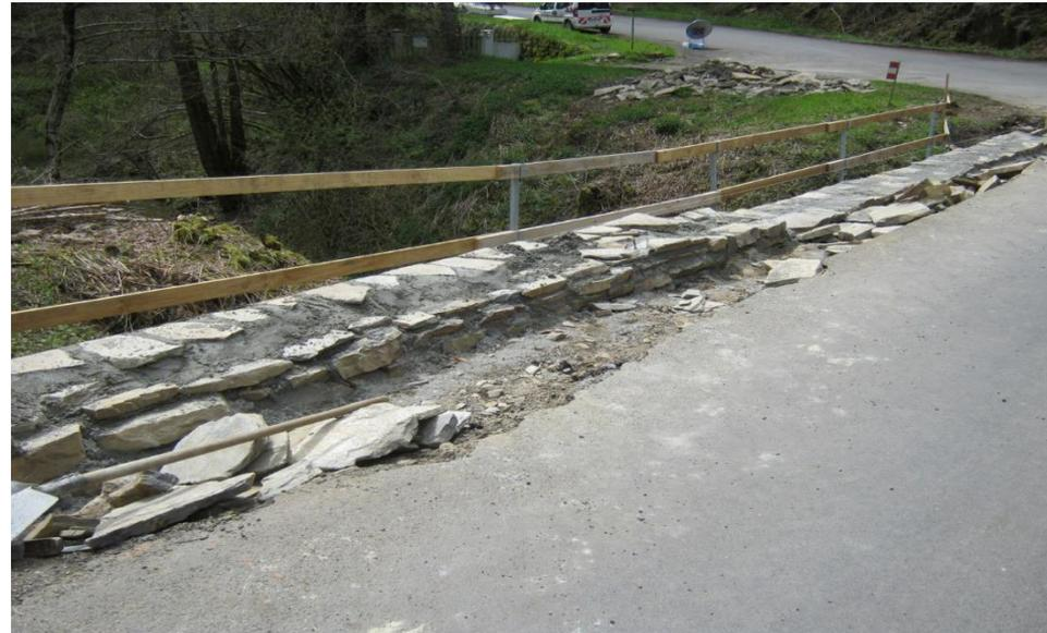
La partie haute des tympans déstructurée par le gel est reconstruite.
