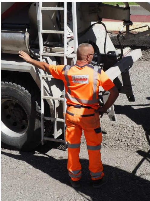
Celui-ci guide la toupie et règle le débit de béton.
