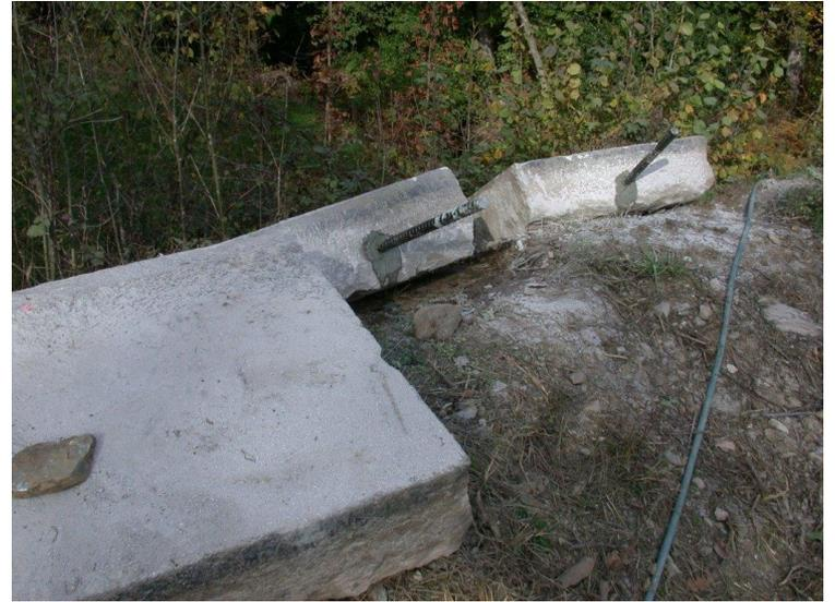
Perçage latéral de chaque pierre et scellement d'un fer à béton.
