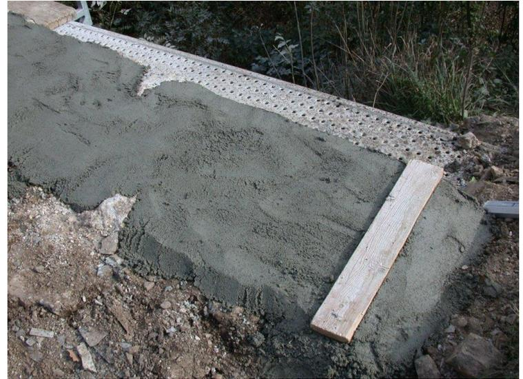
Construction de l'arase en mortier pour la repose des plinthes.
