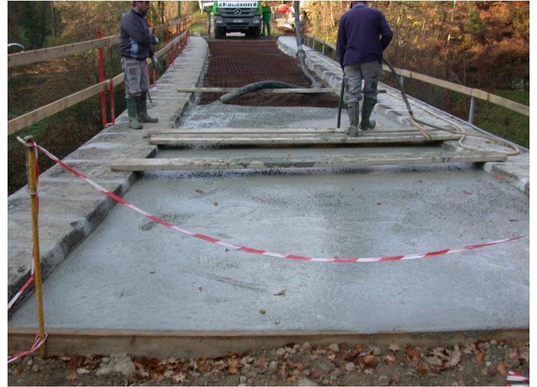
Coulage de la dalle avec la pompe à béton.
