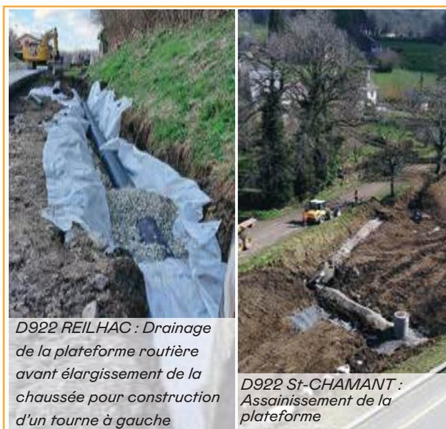
D922 REILHAC : Drainage de la plateforme routière avant élargissement de la chaussée pour construction d'un tourne à gauche
